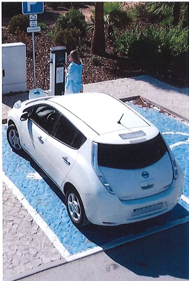
Utilizador Posto de carregamento de veículos elétricos
