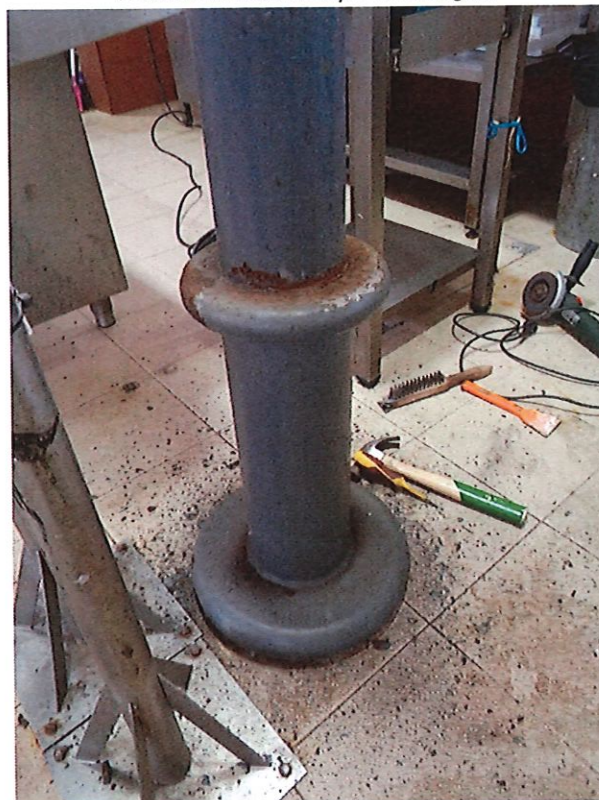
Imagem 23 Tratamento de eliminação de ferrugem
