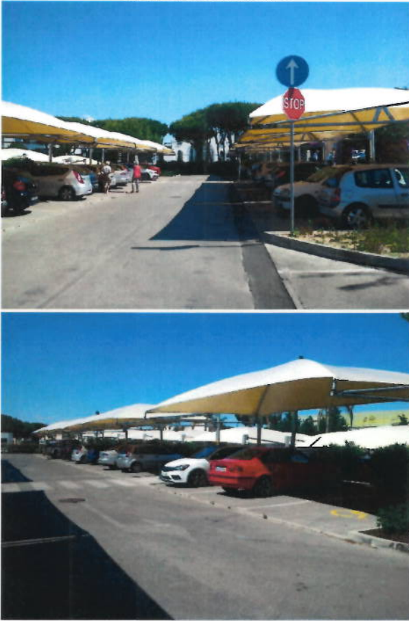
Imagem 36 e 37 Espaço após a intervenção
