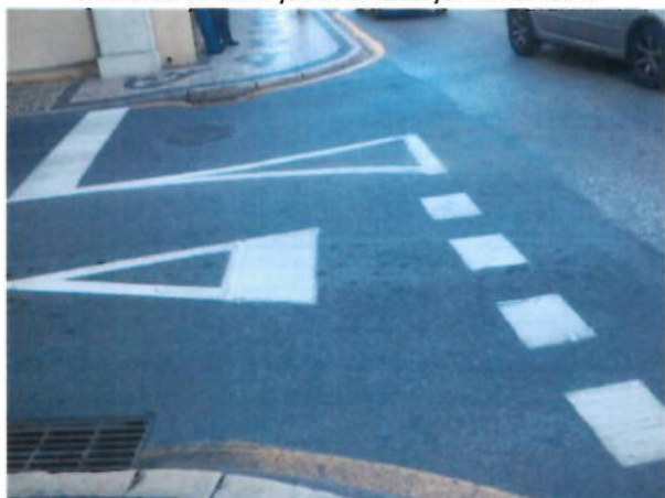
Trabalhos de execução de sinalização horizontal 3
