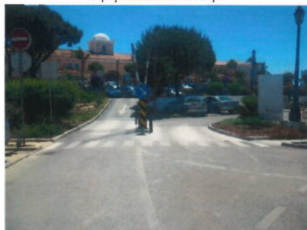
Espaço antes da intervenção
