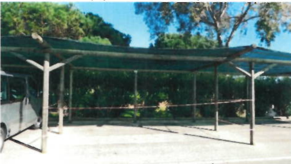
Imagem 38 Espaço antes da intervenção
