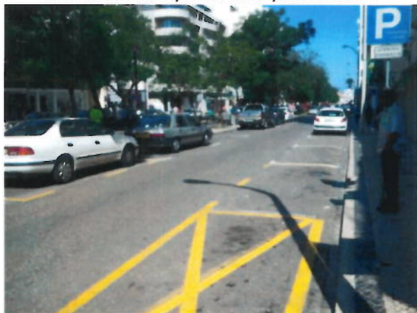
Trabalhos de execução de sinalização horizontal 1
