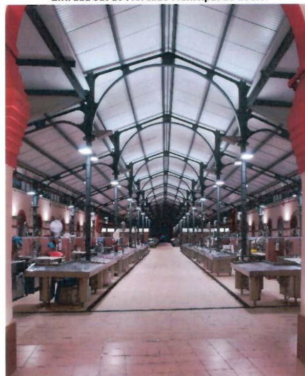
Entrada sul do Mercado Municipal de Loulé
